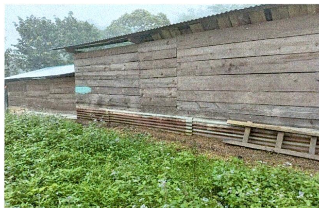
Foto 2: Mejoramiento modulo 3 tipo portico de Cocina
